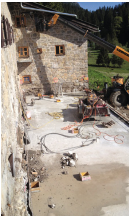
Die Albert-Link-Hütte wurde generalsaniert
