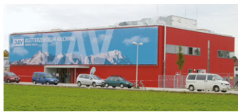
Nach nur 9 Monaten Bauzeit hat die Sektion München des Deutschen Alpenvereins in Gilching eine der größten und modernsten Kletterhallen Deutschlands eröffnet.
