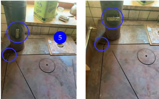
**Abbildung 1.2:** Links: Die Ofenklappen geöffnet zum Anfeuern (senkrechte), rechts nach ca. einer halben Stunde geschlossen (waagrecht)
