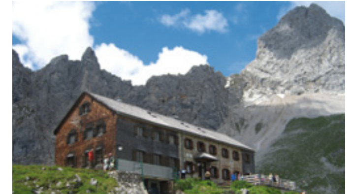
Auf der Lamsenjochhütte stehen diverse Bauprojekte an
