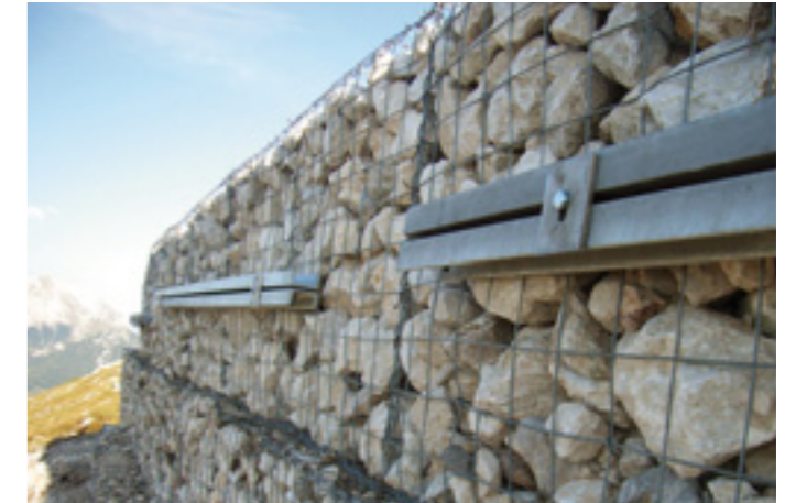
Gabionen verdecken die neuen Trinkwassertanks
