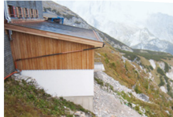
Der neue Anbau für die Energie- und Umwelttechnik
