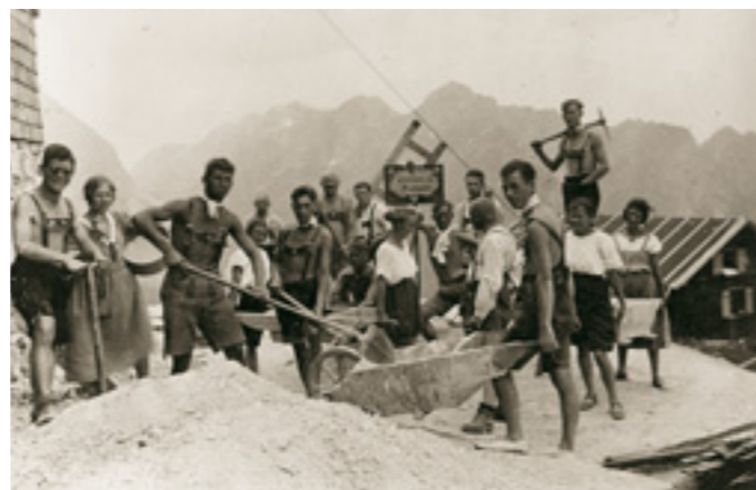
Die Dachauer und Dachauerinnen packen fröhlich an beim Bau der Falkenhütte
