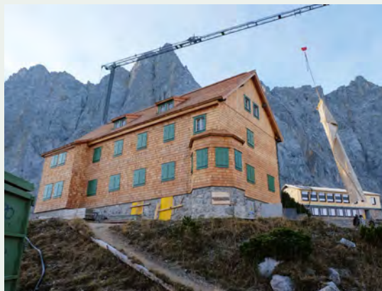
Die Falkenhütte der Sektion Oberland wird nach der Generalsanierung 2020 wieder ein beliebtes Ziel für Mountainbiker sein, jedoch keine E-Bike-Ladestationen anbieten.
